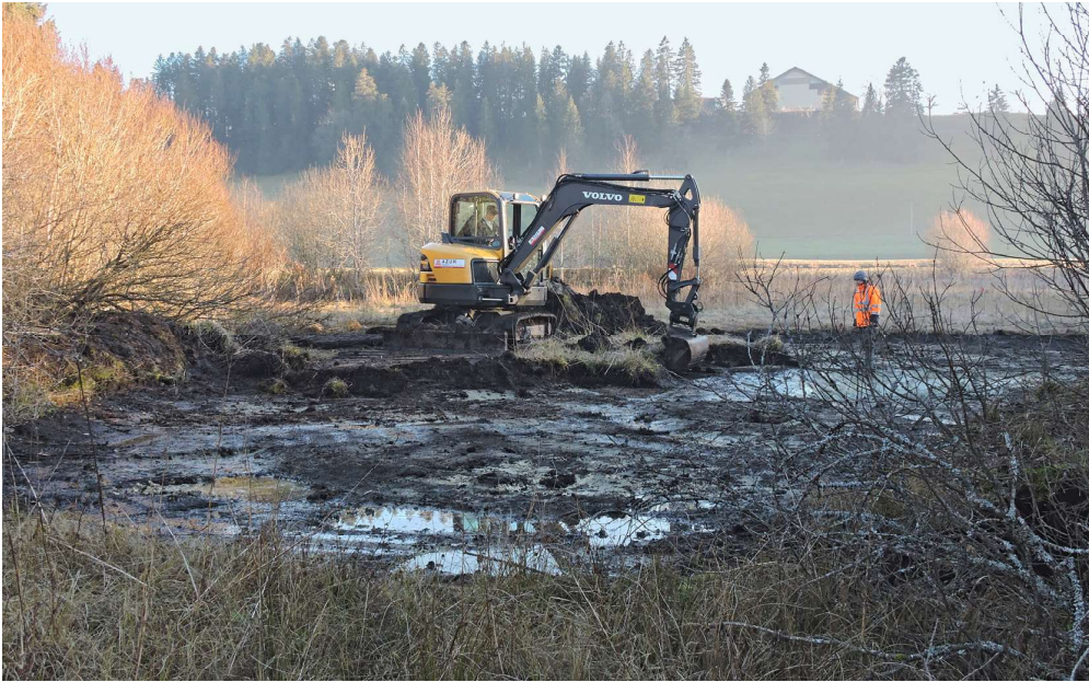
Maschineneinsatz für die Natur: Ein Bagger erstellt kleine Dämme und gräbt Teiche, um das trocken gefallene Moor wieder zu vernässen (Foto: Yvan Matthey).
